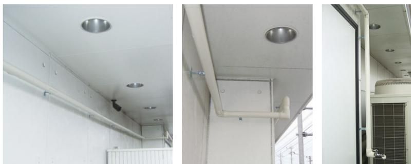
屋外の狭小スペース、高所作業、屋外延長配管、やり替え工事、仮設など、屋外に配管を引き伸ばす現場において、長期間紫外線劣化から守ります。
